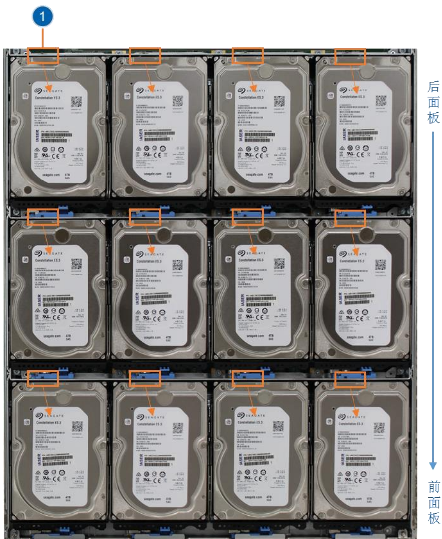
图 3-21 3U 机柜抽屉内硬盘指示灯
